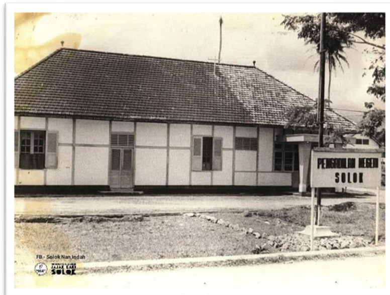
Gambar 1 Gedung kantor Pengadilan Negeri Solok dahulu
