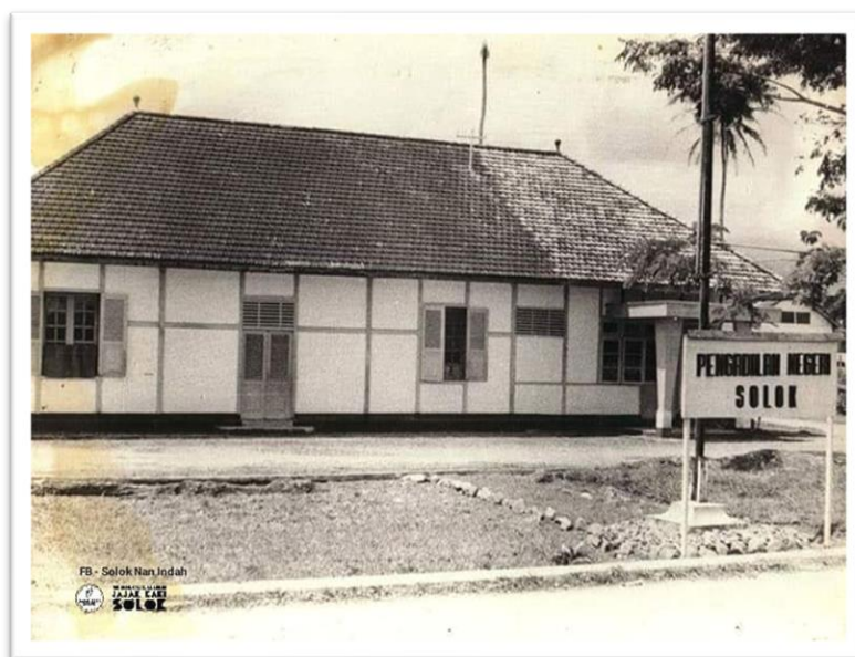
Gambar 1 Gedung kantor Pengadilan Negeri Solok dahulu
