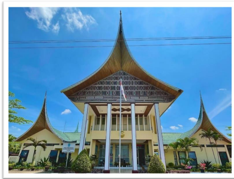
Gambar 2 Gedung kantor Pengadilan Negeri Solok sekarang
